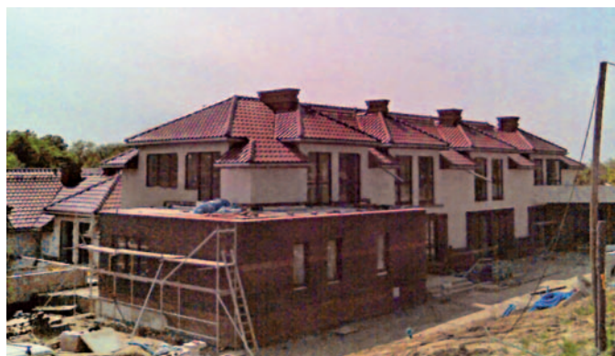
Na budowie Rodzinnego Domu Dziecka i Centrum Wolontariatu w Skawinie k. Krakowa wykonawcą robót dachowych jest firma DACHSPEC
