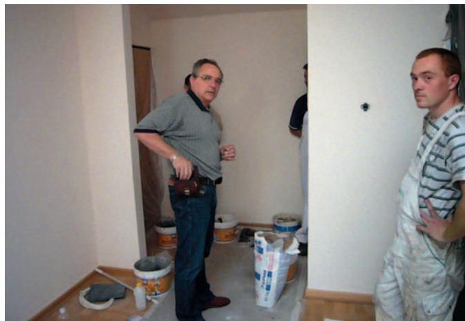
Marek Majkrzak dogląda prac wykończeniowych, realizowanych przez MARK-BUD w domu jednorodzinnym w Warszawie
